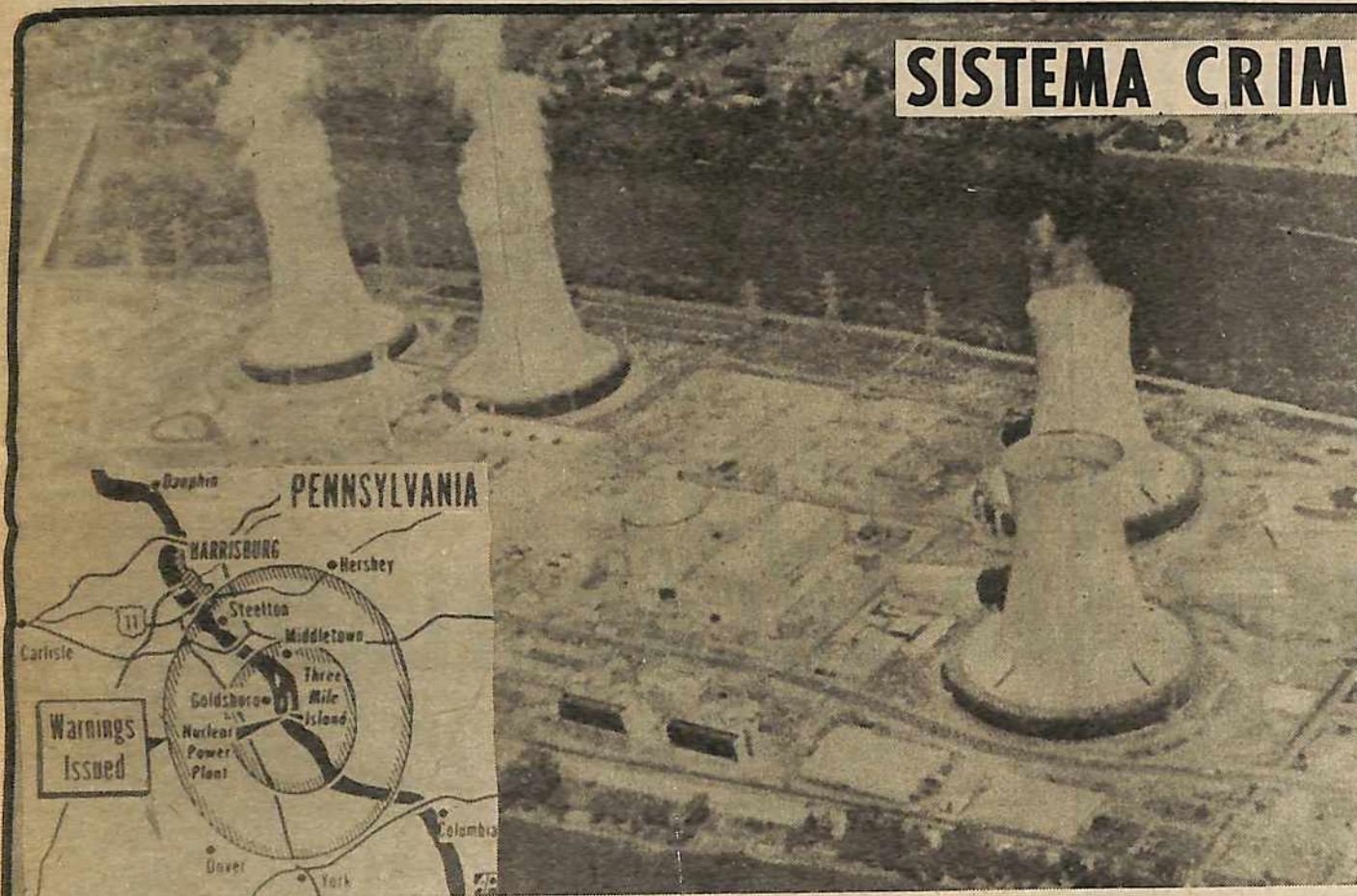
VISTA AEREA DE LA PLANTA NUCLEAR EN THREE MILE ISLAND EN PENNSYLVANIA.
