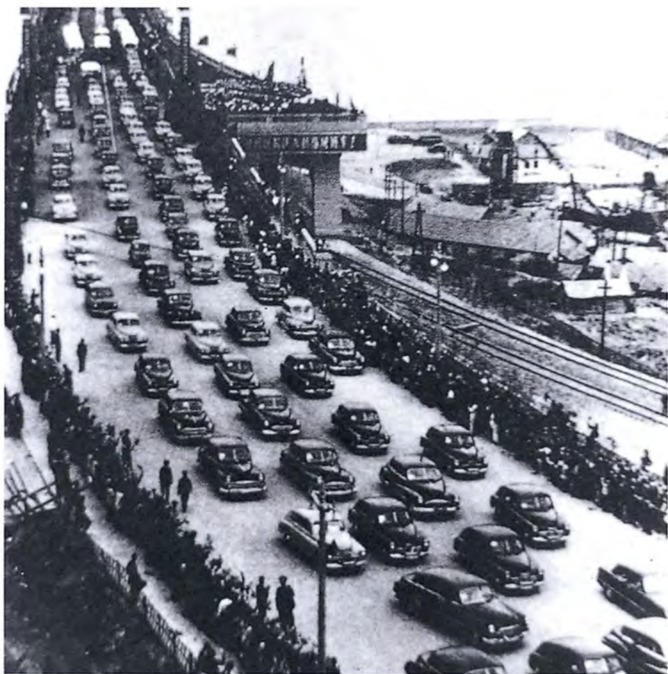
1957年10月25日，武汉长江大桥通车。图为通车典礼上，数百辆汽车驶过长江大桥。
